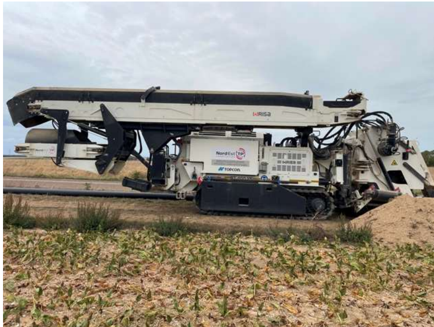
Nord Est TP était en train d'enfouir les 2 tuyaux entre Les Grandes Chapelles et Rilly Saint Syre
